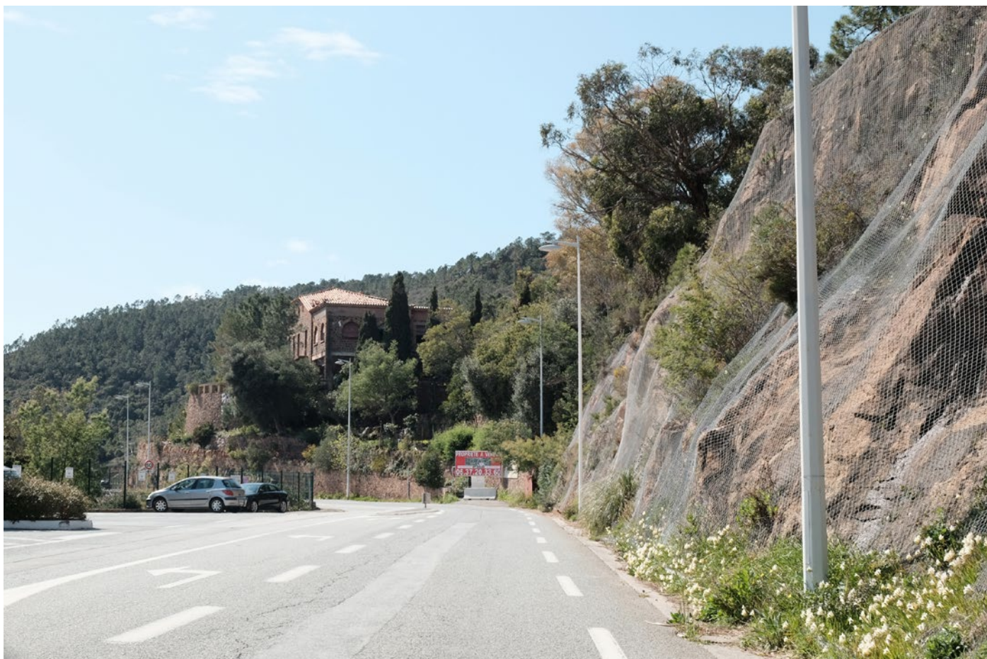
Sur-lageurs d'enrobé sur la route départementale 6098. Les filets de protection contre les éboulements gagneraient aussi à être plus discrets.
