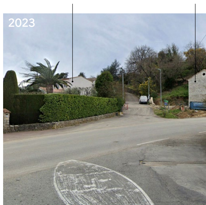
L'urbanisation des pentes d'Auribeau-sur-Siagne conduit à une dégradation du site perché.
