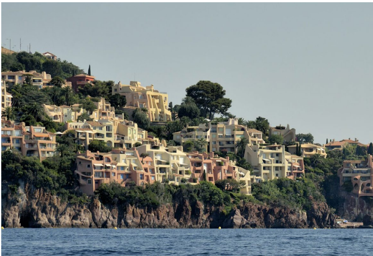
Paysage architectural des années 1970 (architecte Jacques Couëlle), avec une urbanisation littorale en corniche, caractéristique des années d'avant la loi Littoral. Le projet résidentiel, contesté, est aujourd'hui labellisé « Patrimoine architectural XXe siècle ». ©oppvlm
