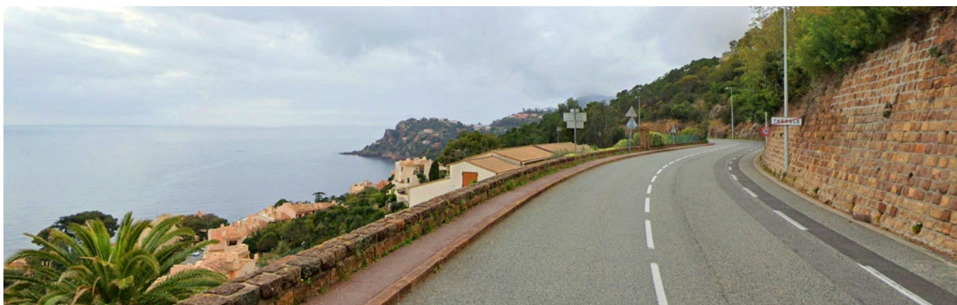
Vue dégagée depuis la route départementale 6098 à Théoule-sur-Mer.
