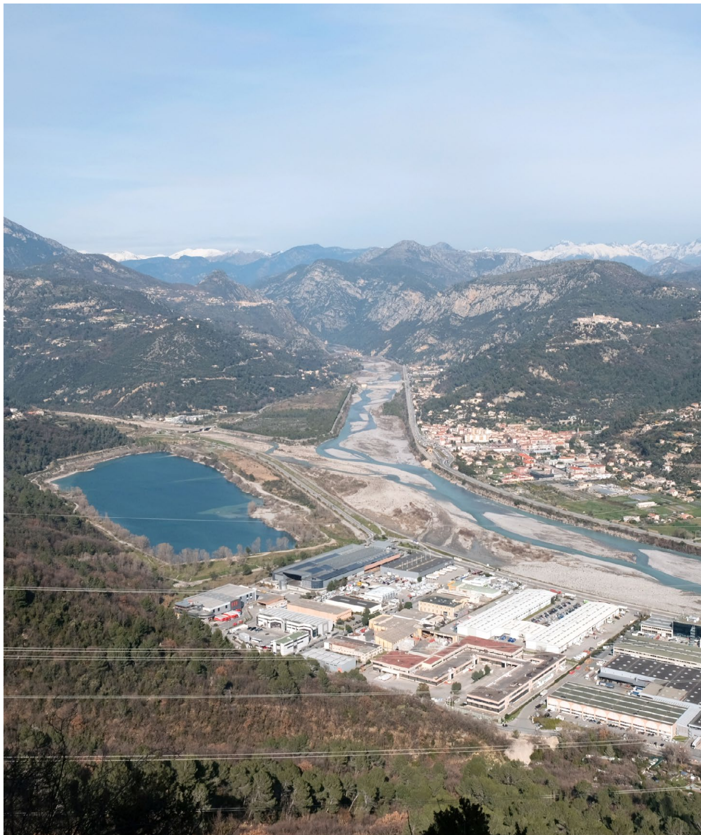
Lac du Broc et Var canalisé.
